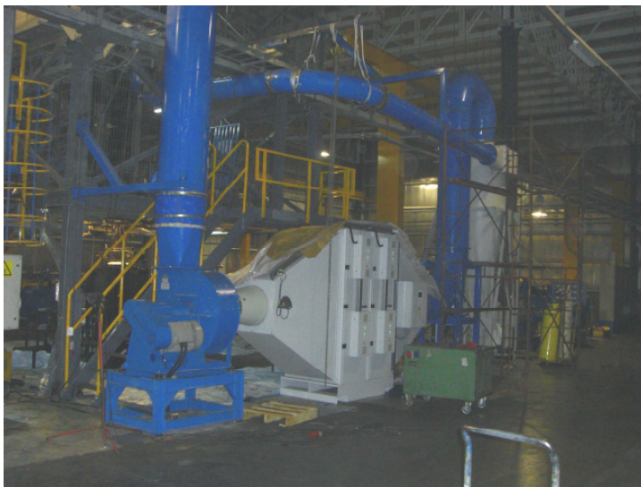
LTA-Filter AC 8002, Gebläse, Zyklon
